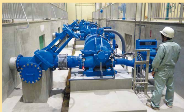
▲大島ポンプ場の送水ポンプ更新工事
