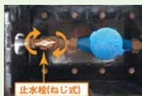
止水栓 (ねじ式) ※矢印のほうにハンドルを回すと止まります。
