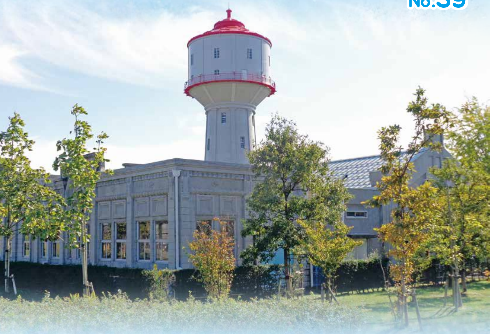
水道公園の水道タンクとポンプ室棟
