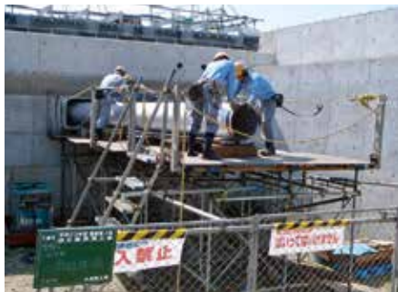
フェニックス大橋に送水管を設置している様子
