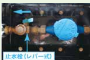
止水栓 (レバー式) ※矢印のほうにレバーを倒すと止まります。
