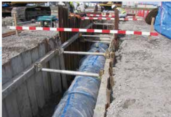
東西道路・左岸バイパス内の耐震管布設の様子
