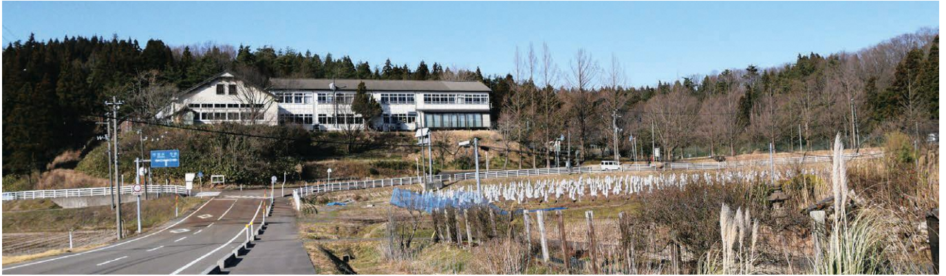
島田小学校(旧長岡市立島田小学校)(現和島トゥール・モンド)
