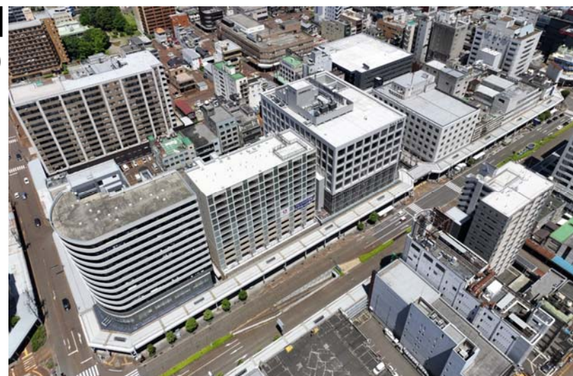
【竣工写真】 (R5.5.31)
