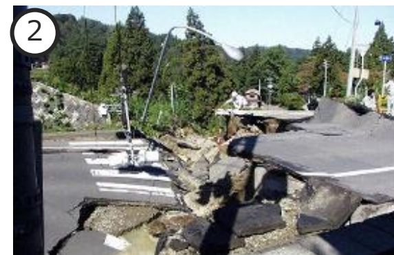
中越大地震により道路崩壊（北荷頃）
