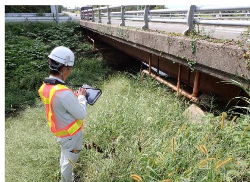
タブレットシステムによる点検
