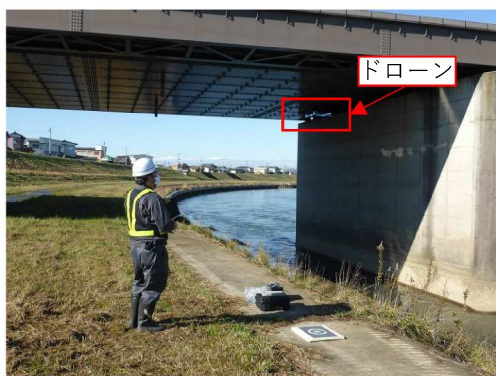
ドローンによる点検
