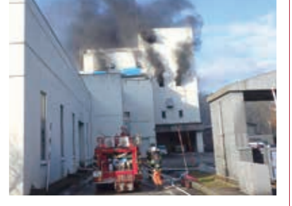
リチウムイオン電池が原因と思われる火災発生した鳥越グリーンセンター(12月13日)
