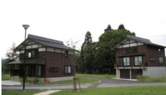
中山間地域の景観と暮らしに配慮した木造の復興公営住宅(山古志地域)
