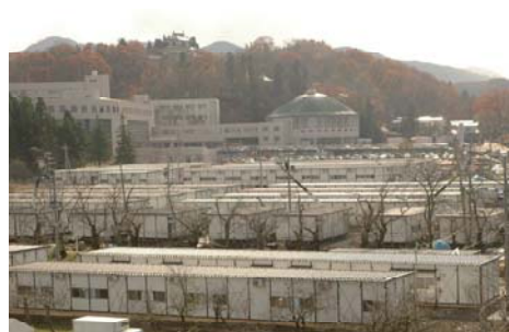
仮設住宅の外観
