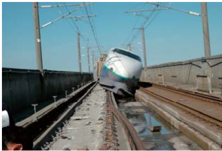
脱線した上越新幹線の車両
