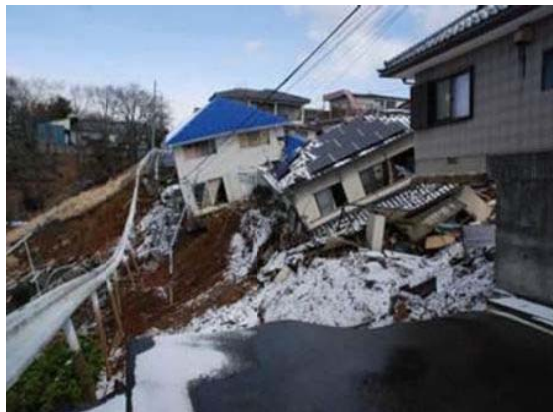
住宅団地の崩落
