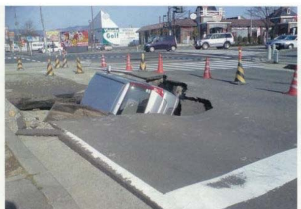
路面の陥没
