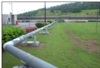
埋設消火配管の地上化 (総長9000m)
