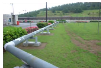
埋設消火配管の地上化 (総長9000m)
