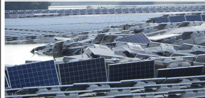
千葉県市原市水上設置型太陽光発電所損壊 (2019年9月台風)
