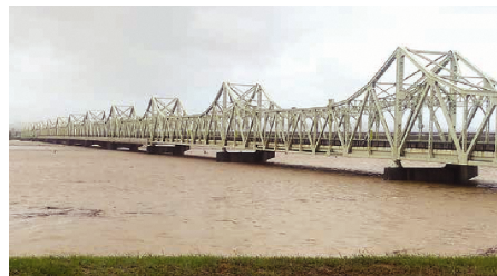
長生橋東詰の様子
