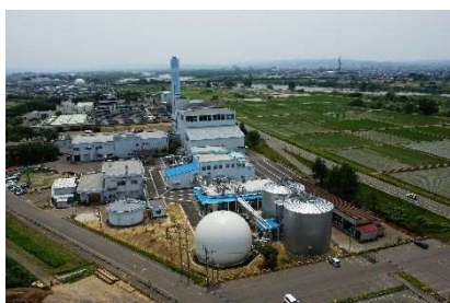
生ごみバイオガス発電センター
