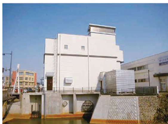
浸水被害の軽減に向けた下水道施設の整備 (西神田排水ポンプ場)
