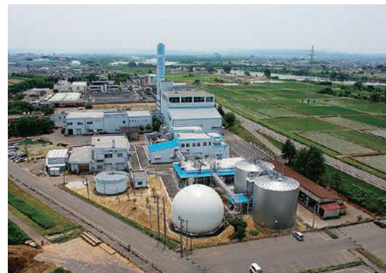
生ごみバイオガス発電センター
