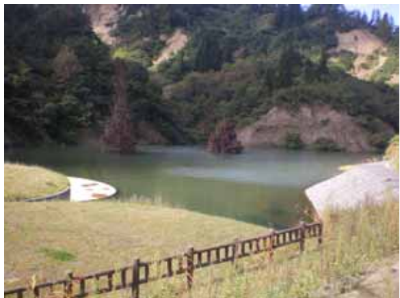
神沢川砂防堰堤（山古志地域）
