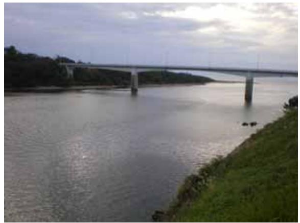
寺泊地域・大河津分水路
