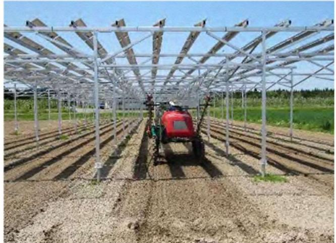
写真 営農型太陽光発電の例
