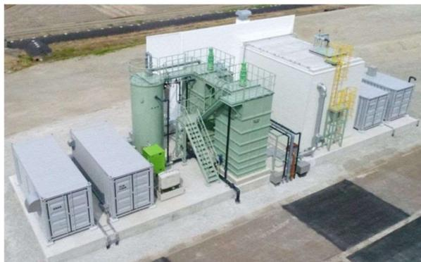
写真 高濃度メタン発酵処理装置
