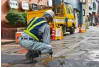
地下水の適正利用に欠かせない消雪パイプの点検作業
