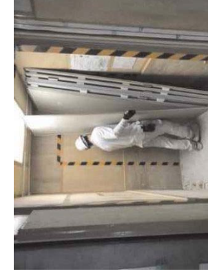
現場内の昇降機を荷物専用として運用
