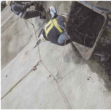
作業時なるべく離隔を確保
