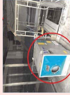
集塵機を設置し室内の換気を実施
