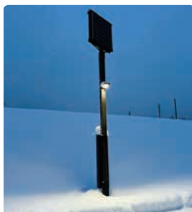
えちご川口温泉登り道路に設置したソーラー照明灯。垂直両面パネルで積雪の影響を考慮しています。
