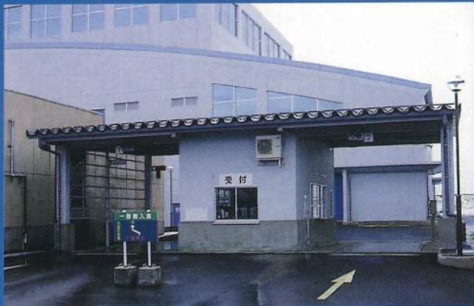
■ごみ計量機 自動的に計算され、記録されます。
