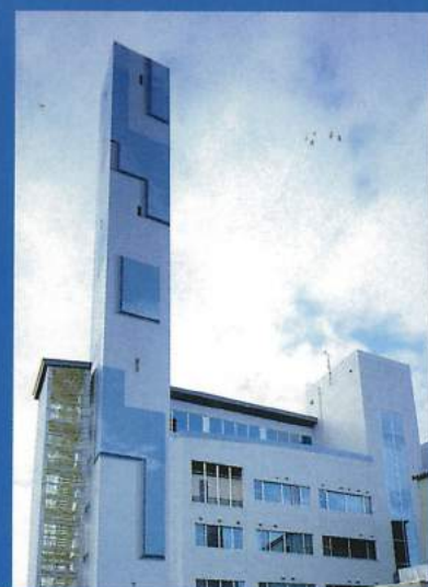
■煙突 デザインは、煙突デザインコンクールで一席になったものです。
