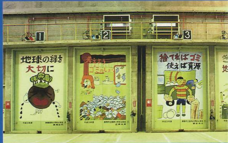
■プラットフォーム 収集されたごみは、ここからピットへ投入されます。
