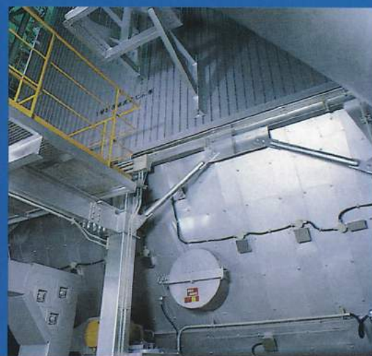
■集じん装置 排ガス中のばいじんは、バグフィルタによって、微細なばいじんまで取り除かれます。
