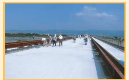
完成間近の橋上写真。このタイミングならではの爽快な景色を紹介します。
