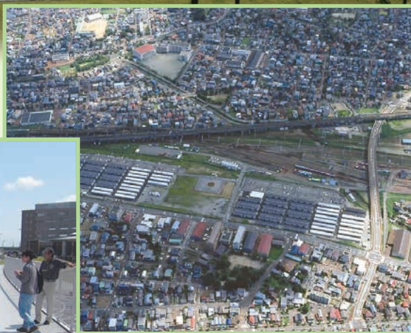
大震災の際には、仮設住宅が建っていました。
