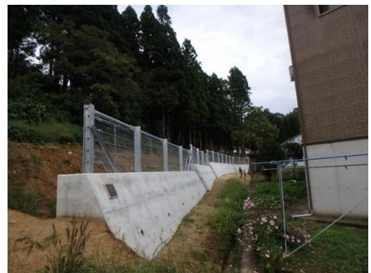
(土砂流入を防ぐ土留め擁壁と防護柵の施工例)
