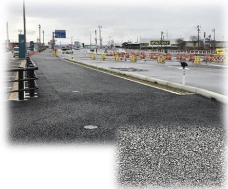
図 2-4-1-18 《道路の透水性舗装》
