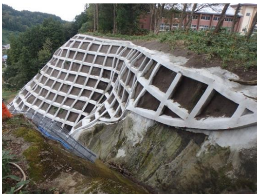
(法面表層部の崩落防止を目的とした吹付砕工の施工例)
