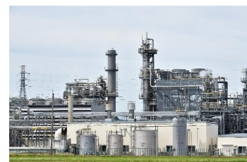
天然ガスプラント
