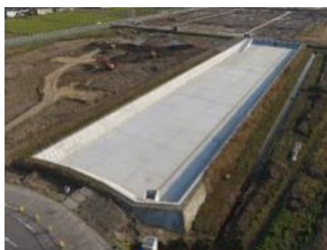
雨水タンクの設置例 雨水調整池（長岡北スマート流通産業団地）
