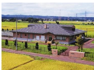
岡南南部浄化センター
