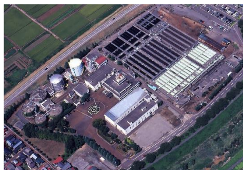
現在の長岡第一下水処理場
