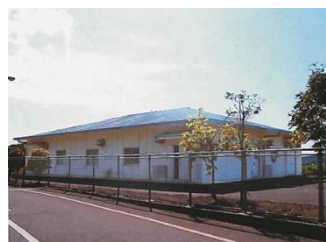
桐原地区集落排水処理場
