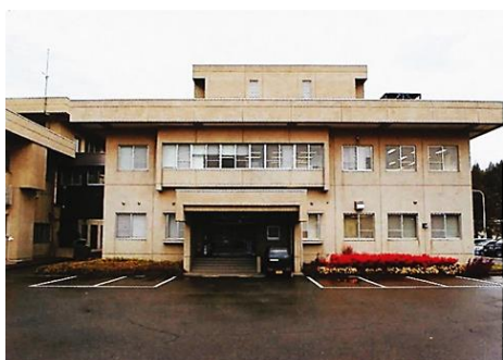
栃尾下水処理センター
