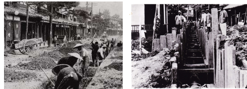
当時の施工状況
