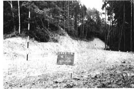
三島林道4号線 荒巻地内
