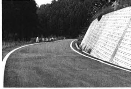
吉浦線 道路舗装
