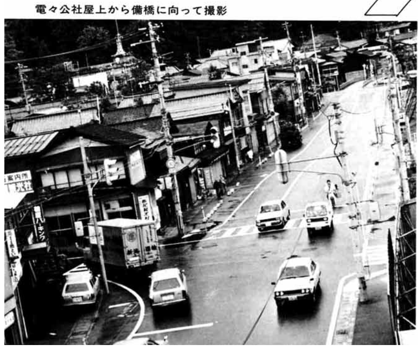
電々公社屋上から備橋に向って撮影
