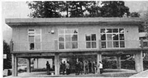
西谷生活改善センター
