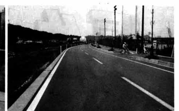
金沢・平堤防線舗装
