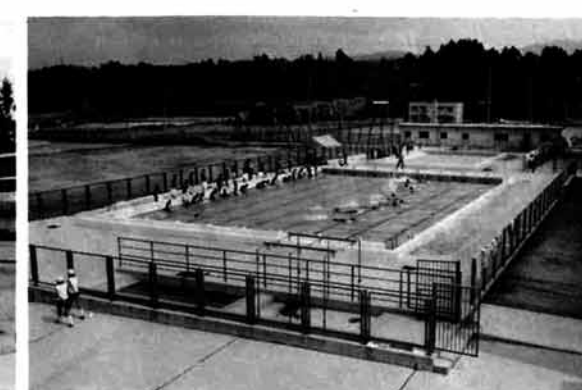
栃尾東小学校プール建設
