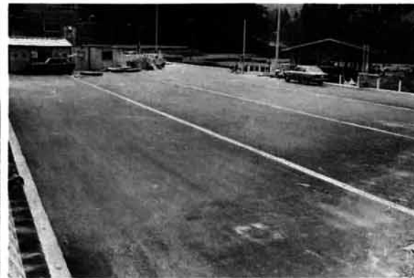
無雪駐車場建設(西中野俣)
