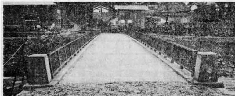
災害復旧事業で完成した小向橋 百三十九、の七・七および四十二年の七・二八の二度の水害で流失した小向橋は、昭和四十二、四十三年度の二か年継続事業で永く橋に生まれ変わりました。工事費は千八百七十七万円で完成は四十四年三月。
