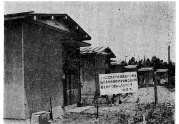
金沢地内に建設した第2種公営住宅 ことしの1月完成した、金沢地内の第2種公営住宅は1棟2戸建が6棟で、現在12世帯が入居しています。総工事費は10,025千円で、このうち20万円は郵政省から簡保資金の還元融資をうけて建設したものです。
