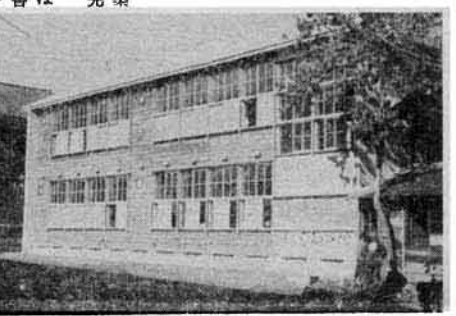
東谷中学校校舎増築完成
