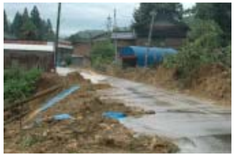
市道山田土ヶ谷本津川線(土ヶ谷地内)
