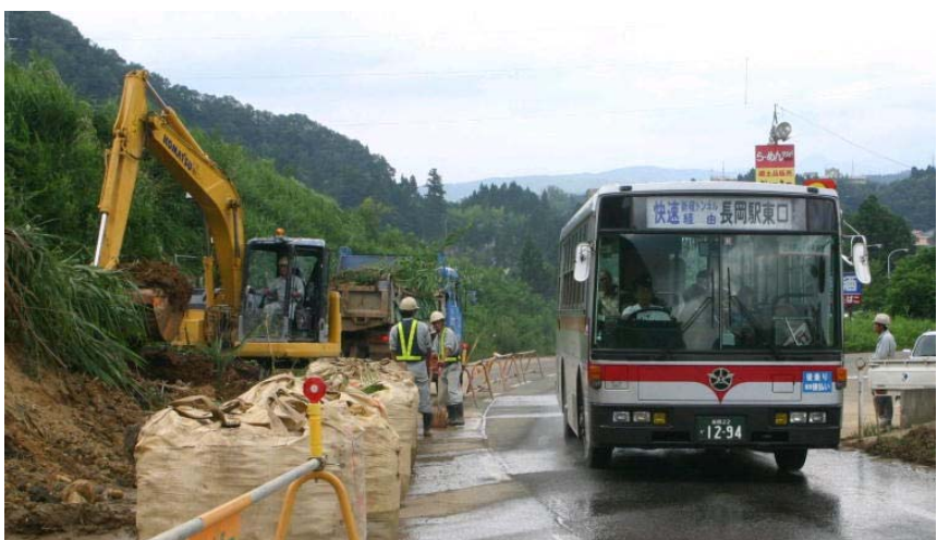
7月14日午後8時に通行止めが解除された国道351号。翌日も安全な通行を確保するため復旧作業が続きました(大野町地内、7月15日)
