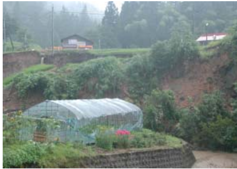
蘆谷川に崩落した水田(蘆谷地内)
