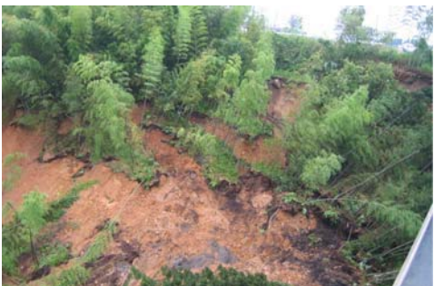
大規模な地すべりが発生した平地区
