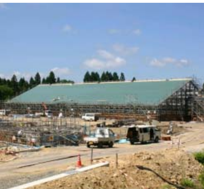
進む入塩川のクリーン工場と、市内で最先端技術を導入している、環境にやさしい最終処分場の建設現場。リサイクルシステムを構築し、廃棄物を最終処分場に処理します。
