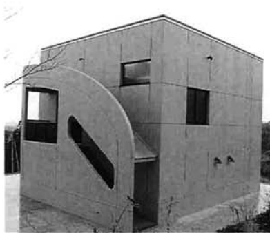
完成した配水池（本所池内）
