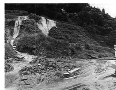
吉水江が崩れ県道が交通止めとなる(平成10年8月4日、大川戸地区)
