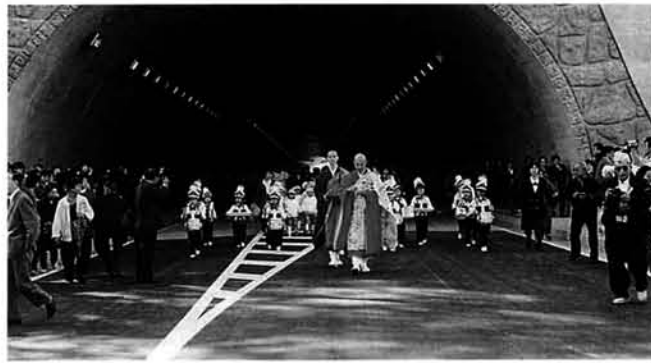
▲マーチングバンドのリズムに合わせてトンネルを渡り、下町側へ抜ける
