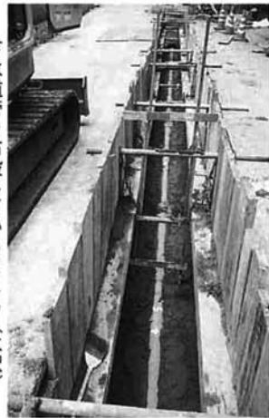
下水道管を布設しているところ（水沢）
