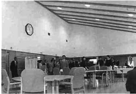
床暖房を完備。天井は高く傾斜があり、匂いがこもらないように配慮してあります
