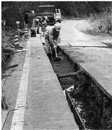
水源付近での工事（入塩川）
