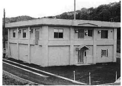
鴉ヶ島地区の浄化センター（処理場）
