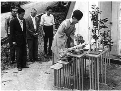
本所地区内の工事の無事を祈りお払い
