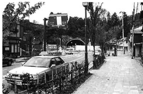
完成間近の秋葉トンネル
