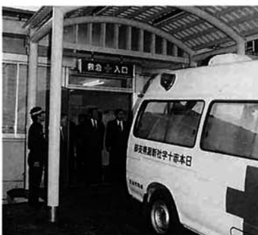
完成した救急入口
