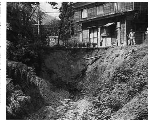
豪雨で地すべりが発生(北河内地区) H7.7.17
