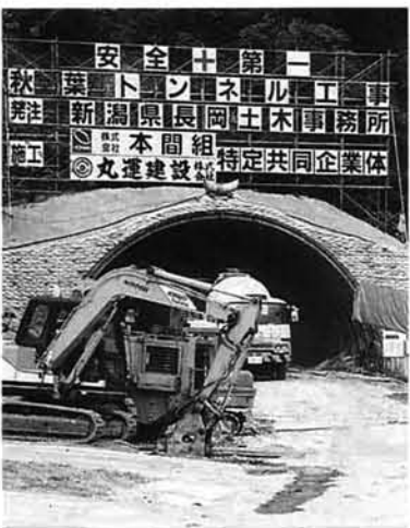
掘削が進む秋葉トンネル
