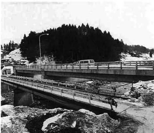
国道290号線バイパスの宮沢橋
