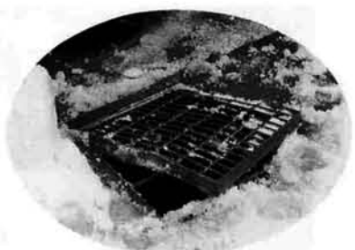
流雪溝のフタを開いたままにしておくと、除雪車がひっかけて、こんなに曲ってしまいます
