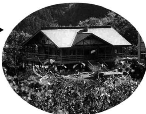
来春オープン予定の食堂棟道院周辺は順次整備が進められています
