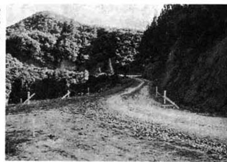
国道290号改良前 守門村石峠付近
