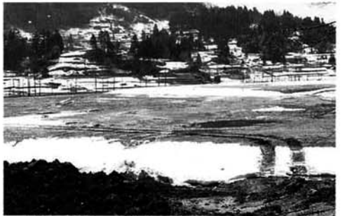
造成工事中の北荷頃工業団地。今年度中に分譲開始を予定している。
