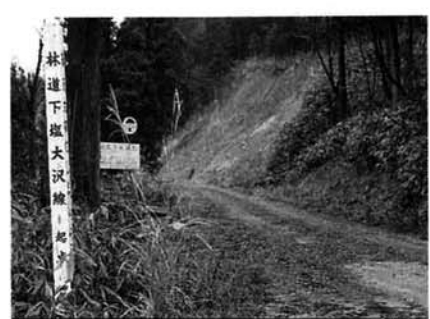
昨年完成した林道下堰～大沢線。林業の生産基盤整備に林道の開設工事は欠かせない。
