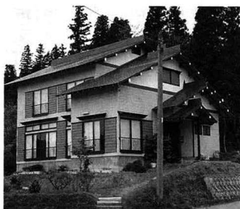
市内でも見られるようになった克雪住宅 （写真は中村幸雄さん（比礼）の高床式落雪住宅）
