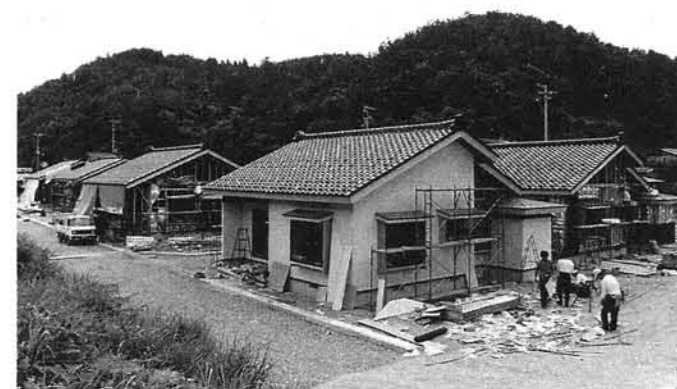
7月下旬に完成する二ノ関団地
