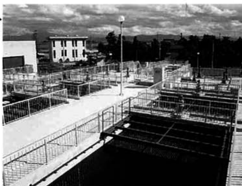
浄水場沈澱池
