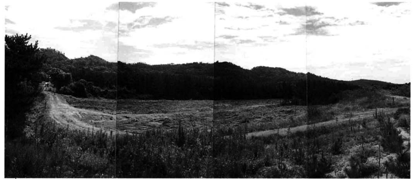
伐採の完了した処理場用地
